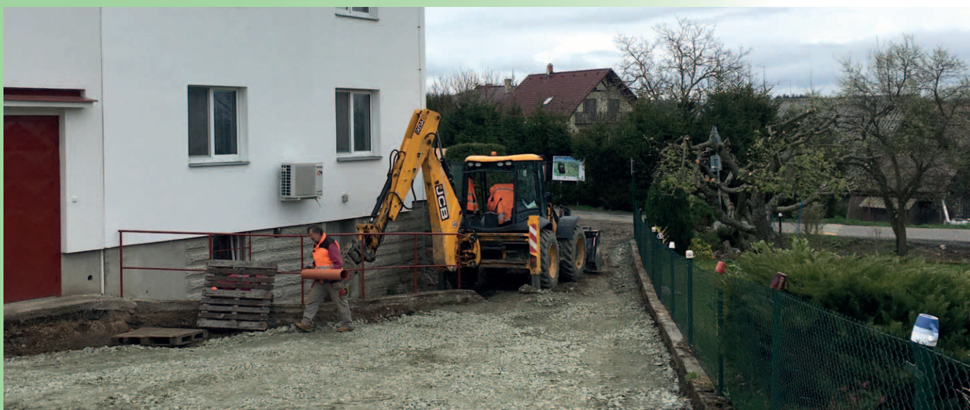
Na úpravě komunikace u Obecního úřadu už se taky pracuje
