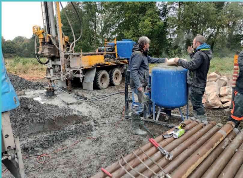
Vrtací práce, 1 záběr z kamery v útrokách země a terén na Žampašce
