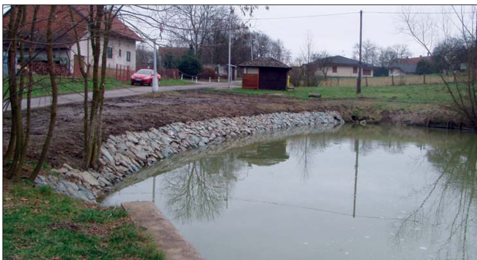
Zpevněný břeh rybníčku na Pasekách
