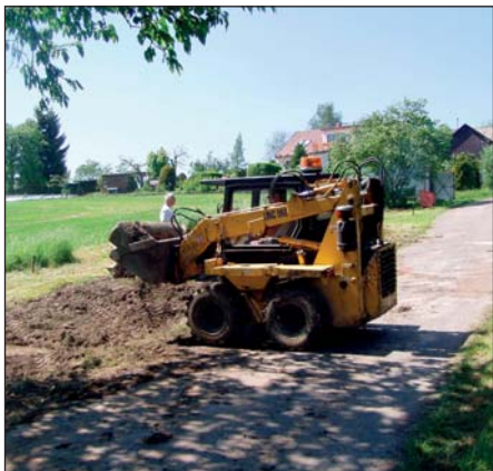
Výměna potrubí v Malé Ledské
