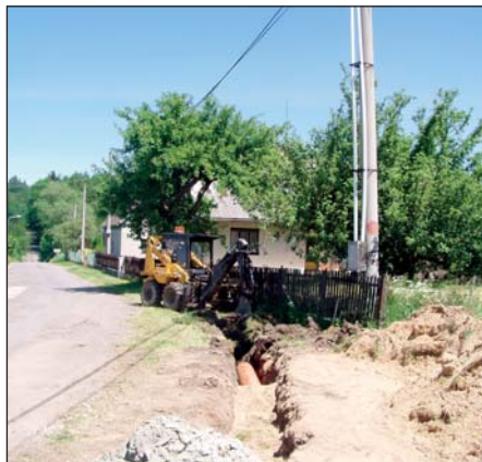
Oprava kanalizace ve Velké Ledské
