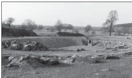
Příprava dočišťovací nádrže
